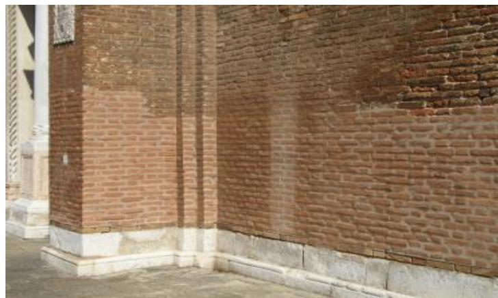
Cuci e scuci della muratura
